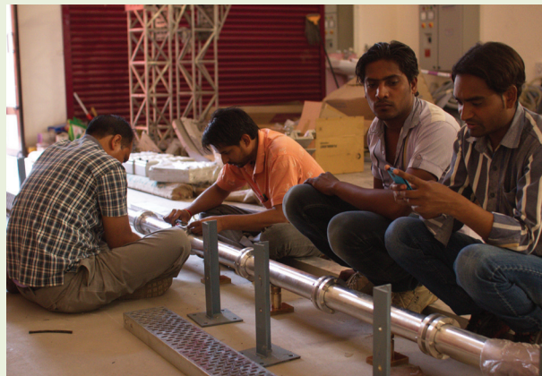
Сборка линии передачи, поставленной ГИКОМом, в Институте физики плазмы в Индии
